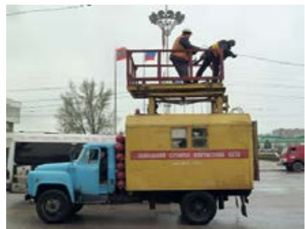
○ Lastbil i Sovjet-stil med platform øverst til reparation af strømførende ledninger til bybusserne.
